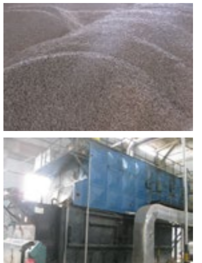
南宁、韶关、随州公司使用生物质生产蒸汽
