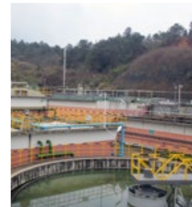
杭州公司污水处理站
